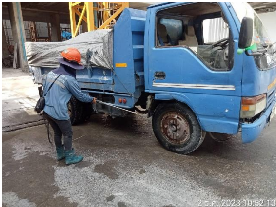
รูปที่ 15 รถบรรทุกปิดคลุมผ้าใบ และล้างล้อรถบรรทุกก่อนออกจากพื้นที่โครงการ
