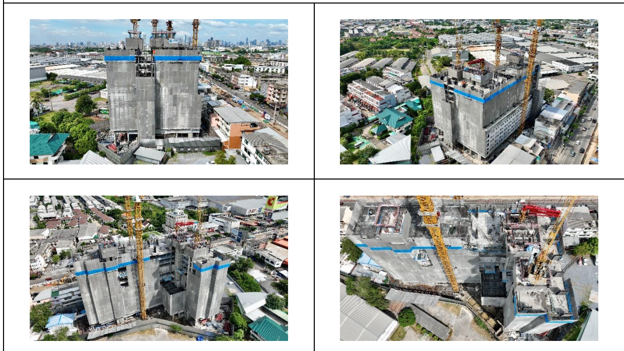
รูปที่ 13 การติดตั้ง Mesh Sheet และ Safety net
