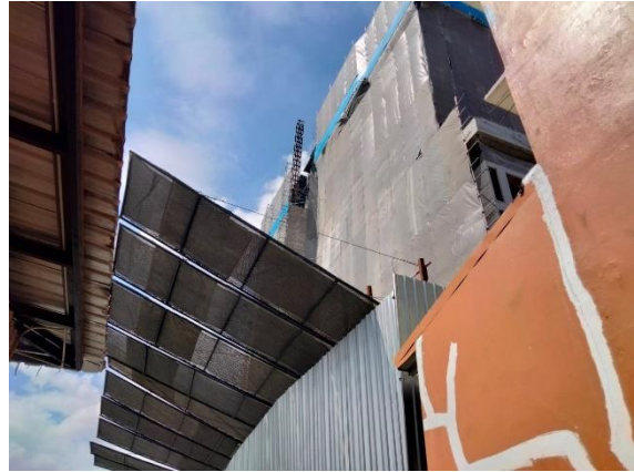
รูปที่ 13 การติดตั้ง Mesh Sheet และ Safety net (ต่อ)
