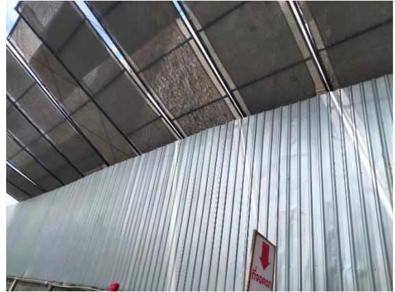
รูปที่ 4 รื้อ Metal sheet (ต่อ)
