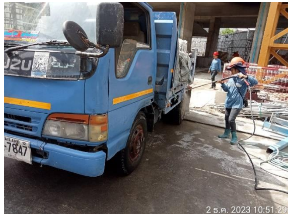
รูปที่ 15 รถบรรทุกปิดคลุมผ้าใบ และล้างล้อรถบรรทุกก่อนออกจากพื้นที่โครงการ
